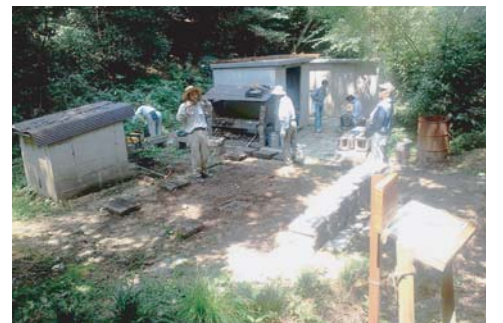
▲古いデッキを撤去。新しいデッキの完成が待ち遠しい
