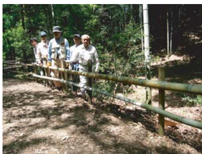
▲補修後の竹柵 (相生口周辺)
