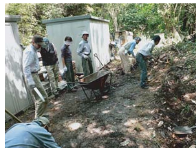
▲「オアシス土木」の作業風景
