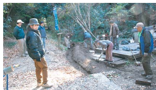
▲ウッドデッキ周辺の排水路整備
