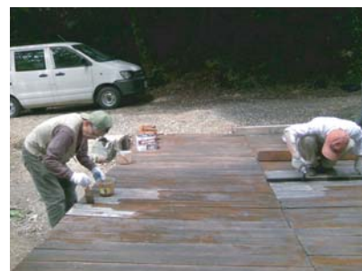
▲デッキの補修作業のようす
