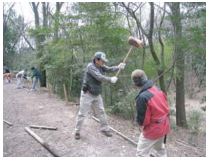
▲木杭を1.5m間隔で打ち込む
