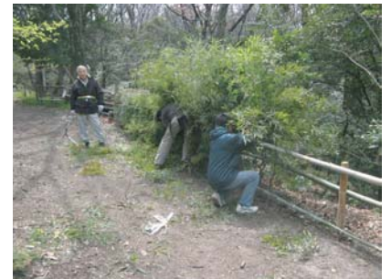
▲木杭を挟み込むように水平方向に竹を三段結束し、その間に葉のついた枝をギュッと押し込む
