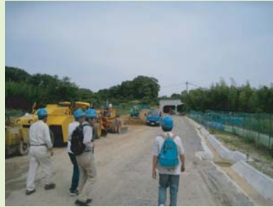
▲現場詰所付近 (奥にシェルター構造部が見える)
