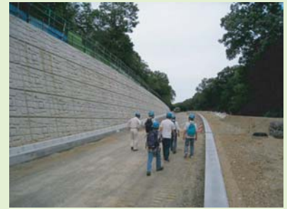
▲地形改変を抑えるために設置された擁壁が続く区間
