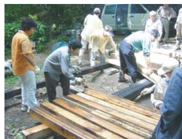
▲黒くなるまで焼いた土台の上に新しいデッキ材を据え付ける
