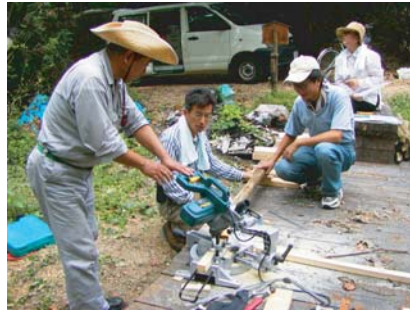
▲解説板が見やすいよう斜めに一定の角度で設置するため、杭に加工を施す。
