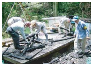
▲火災現場の後片付けに追われるくらぶ員
