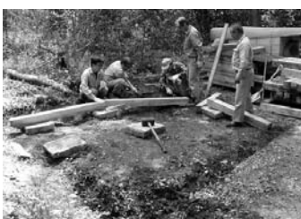
敷石の上に桁となる角材を並べる
