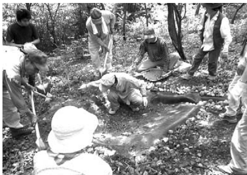
防水シートを敷いた後、周囲を石や丸太で押さえて固定。シートの浮き上がりを抑えるため、真ん中にも重りにならざるを並べる。
