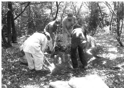
地面を掘り始めると、すぐに石混じりの固い土の層が現れた。ツルハシでほぐしながら適度な大きさと深さまで掘り進める。
