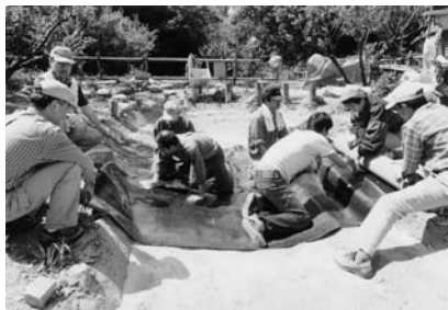
(株)ホージュンの担当者に施工指導を受けながら、我々の手で池底にシートを張り、テープで接着していった。
