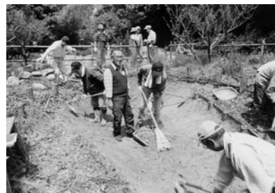
トンボ池底の整形作業として草取り、地均し、礫の除去、突き固め等の作業をおこなった。
