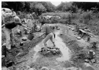
前日までに降った雨が溜まり、防水性能が確かめられたが、この日の仕上げ作業のために水をかい出す必要があった。
